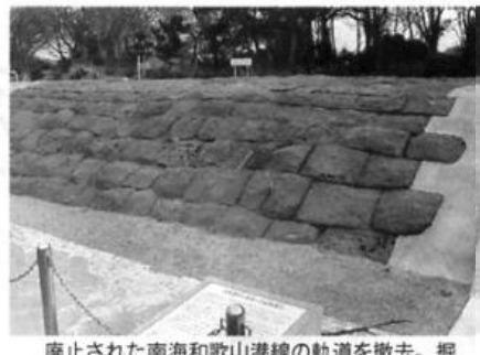
廃止された南海和歌山港線の軌道を撤去。掘り出された水軒堤防の一部がすぐそばに移築・復元されている
