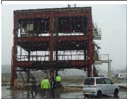
南三陸町防災センター
