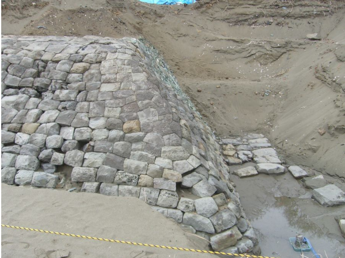
水軒堤防南端部調査 2007.3.25
